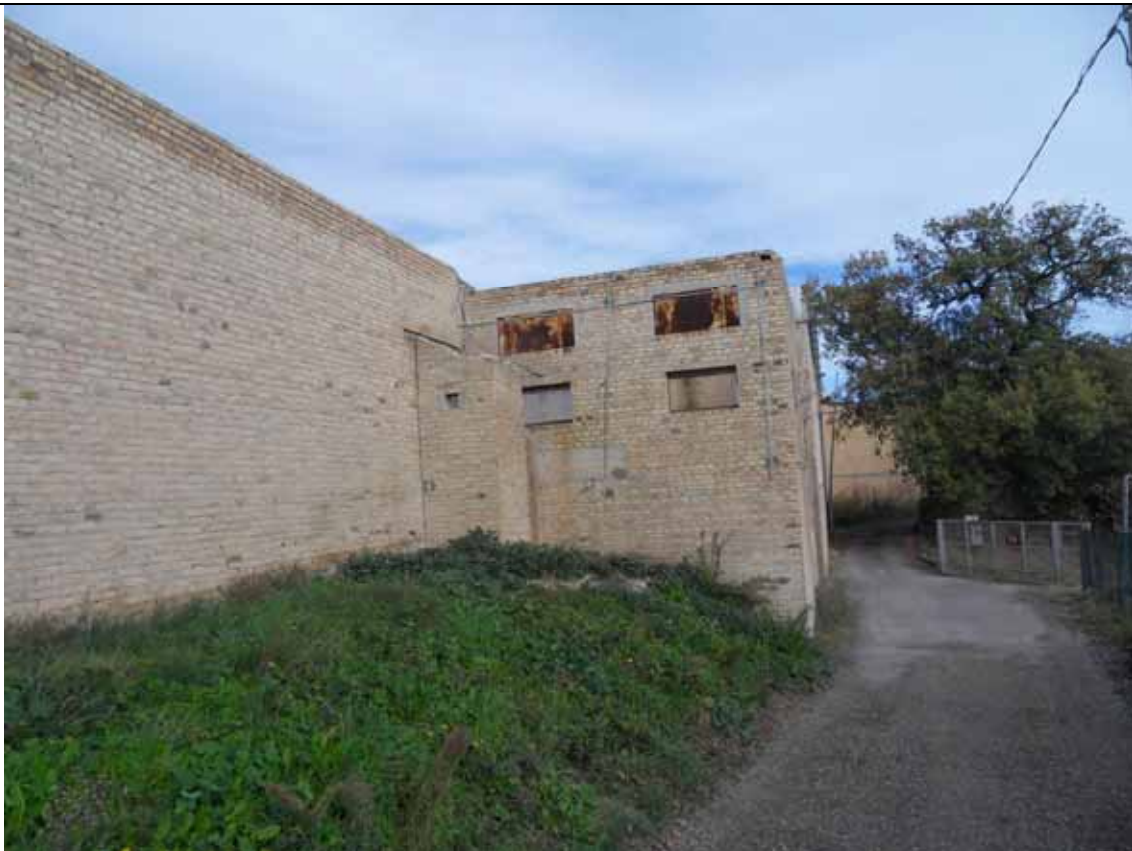
Foto n° 18 – Particolare della recinzione dell'area Ex Spea S.p.A. vista da Via Acquaviva
