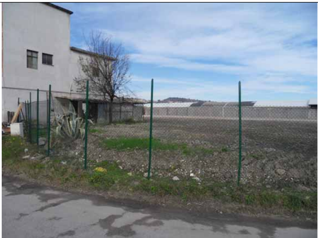
Foto n° 16 – Particolare della recinzione dell'area Ex Spea S.p.A. vista da Via Acquaviva
