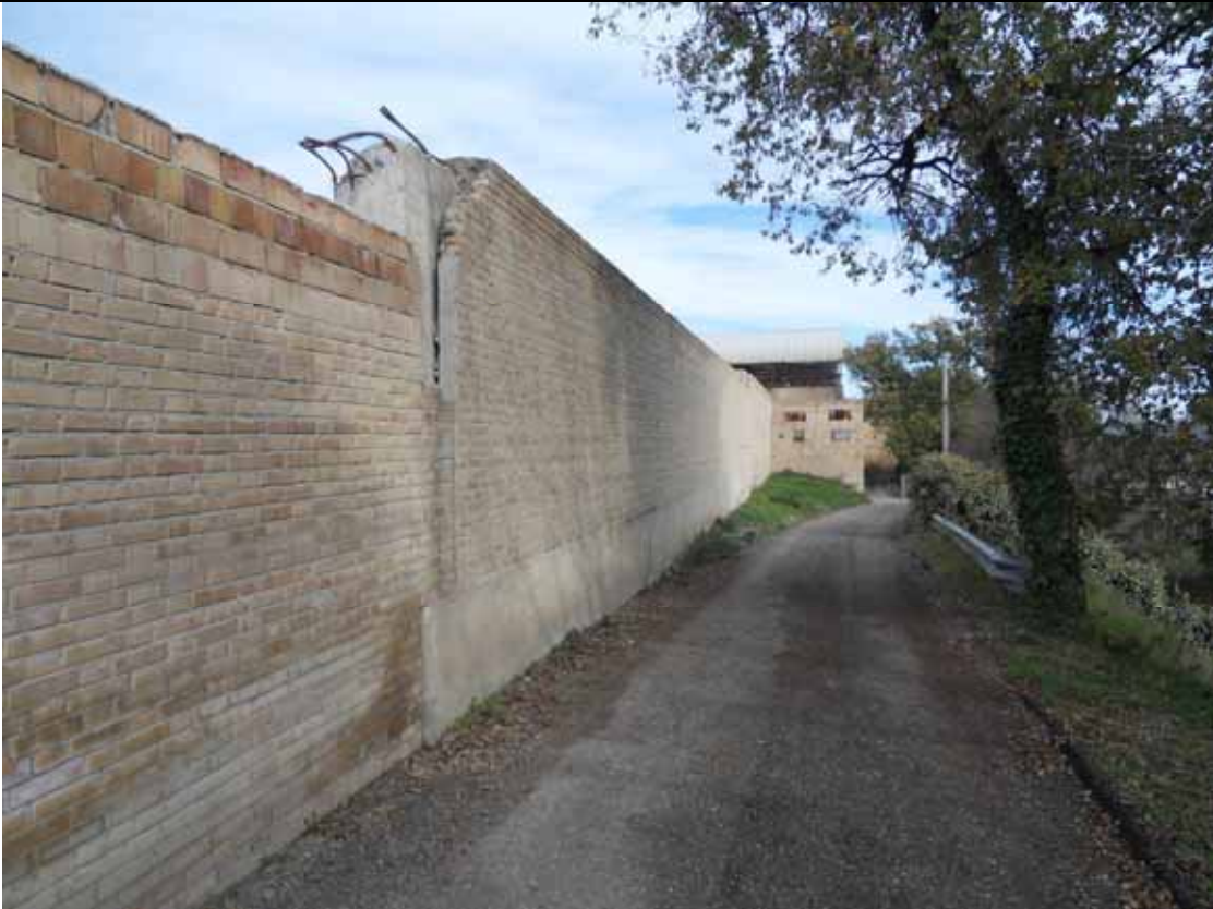
Foto n° 17 – Particolare della recinzione dell'area Ex Spea S.p.A. vista da Via Acquaviva
