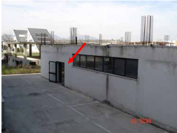
FOTO n° 1: Vista ingresso locale magazzino piano terra lato Sud.
