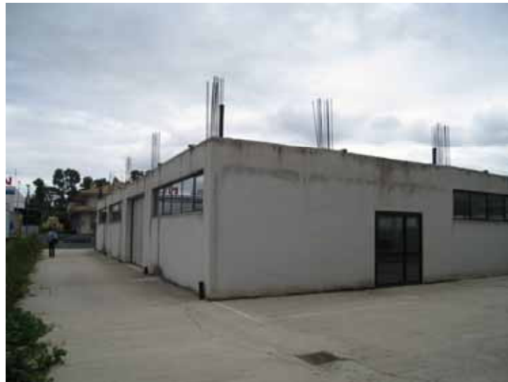
FOTO n° 2: Vista ingresso locale magazzino piano terra lato Sud-Ovest.
