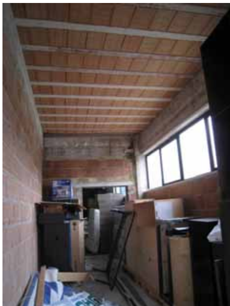
FOTO n° 21: Vista interna locale ufficio piano terra.
