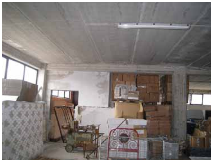
FOTO n° 18: Vista interna locale magazzino piano terra.
