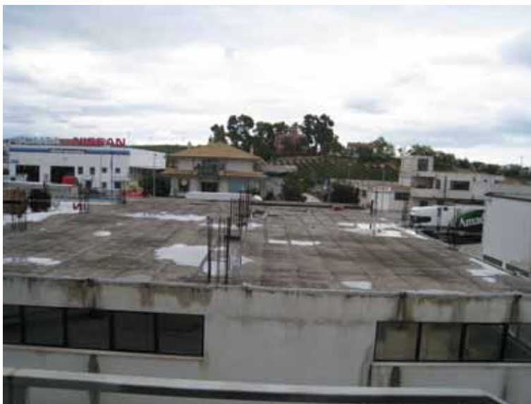
FOTO n° 4: Vista copertura fabbricato.
