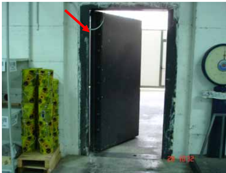
FOTO n° 11: Vista parete separazioni locali piano sottostrada e particolare porta blindata.
