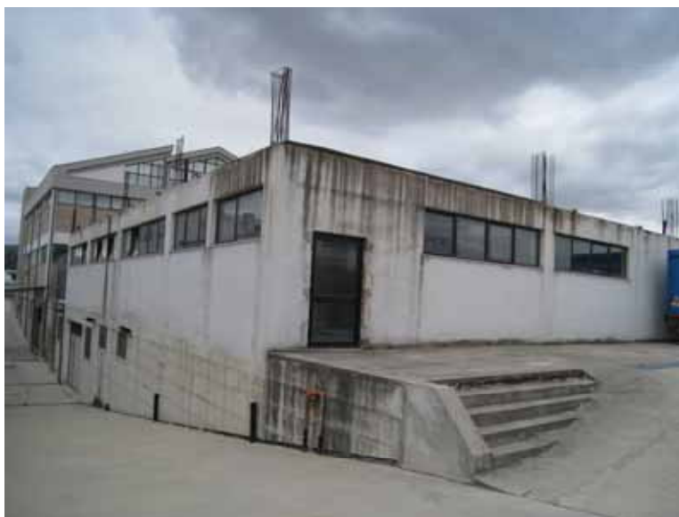
FOTO n° 5: Vista rampa carrabile di accesso piano sottostrada lato Nord-Est.
