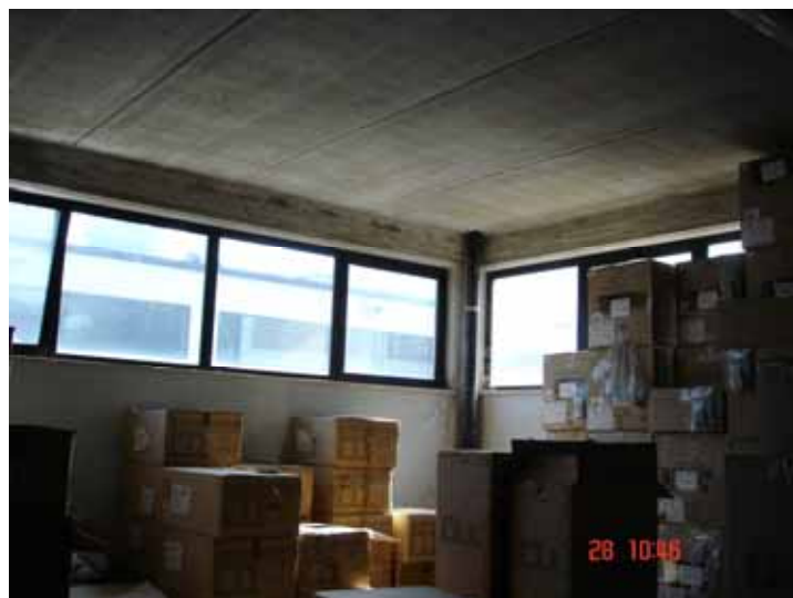
FOTO n° 24: Vista interna locale magazzino piano terra.
