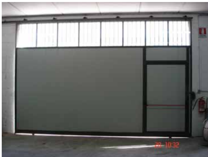
FOTO n° 12: Vista ingresso carrabile piano sottostrada.
