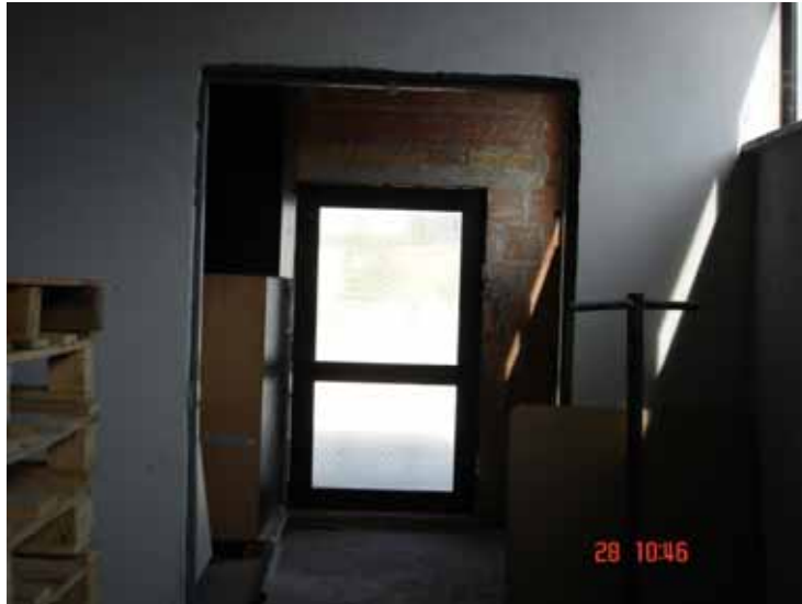
FOTO n° 25: Vista interna locale ingresso-ufficio al piano terra.
