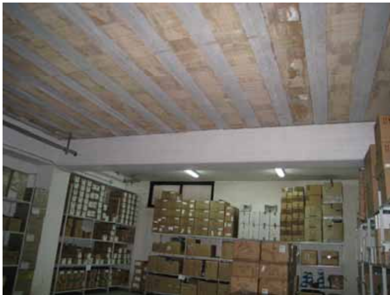
FOTO n° 8: Vista locale magazzino piano sottostrada.
