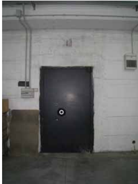
FOTO n° 10: Vista parete separazioni locali piano sottostrada e particolare porta blindata.
