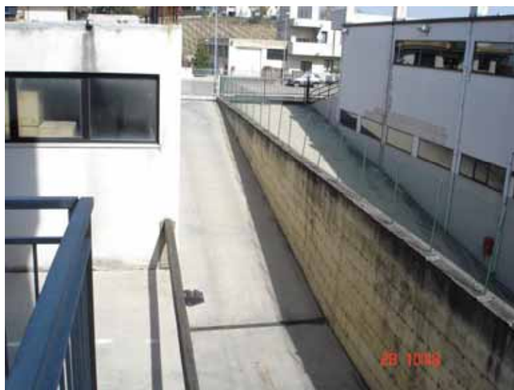
FOTO n° 3: Vista rampa carrabile di accesso piano sottostrada lato Est.
