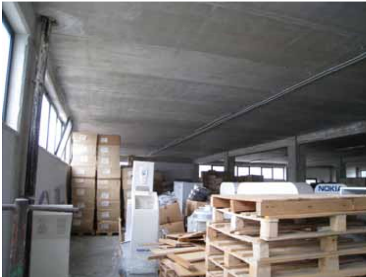
FOTO n° 20: Vista interna locale magazzino piano terra.
