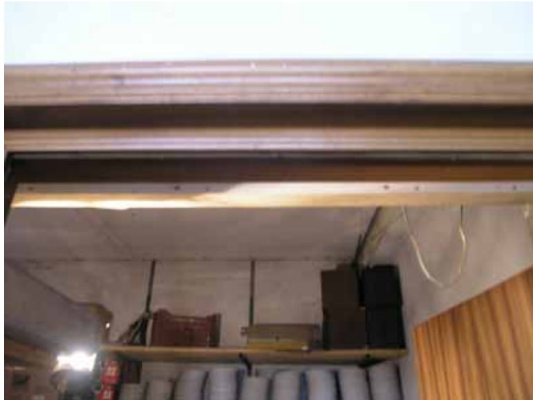
FOTO n° 4: Vista interna locali al Piano 1° Sottostrada.
