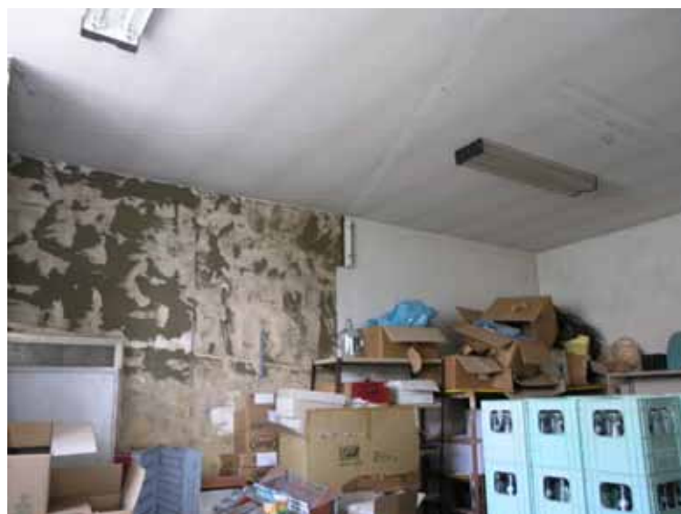
FOTO n° 6: Vista interna locali al Piano 1° Sottostrada.
