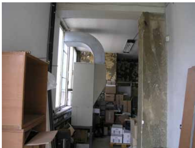
FOTO n° 9: Vista interna locali al Piano 1° Sottostrada.
