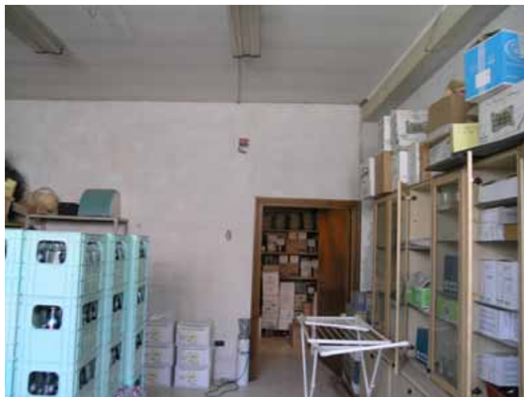
FOTO n° 5: Vista interna locali al Piano 1° Sottostrada.
