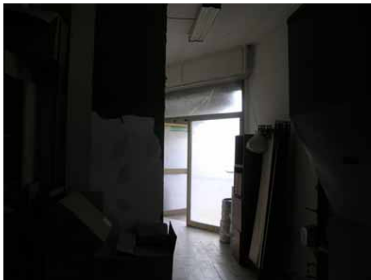
FOTO n° 8: Vista interna locali al Piano 1° Sottostrada.
