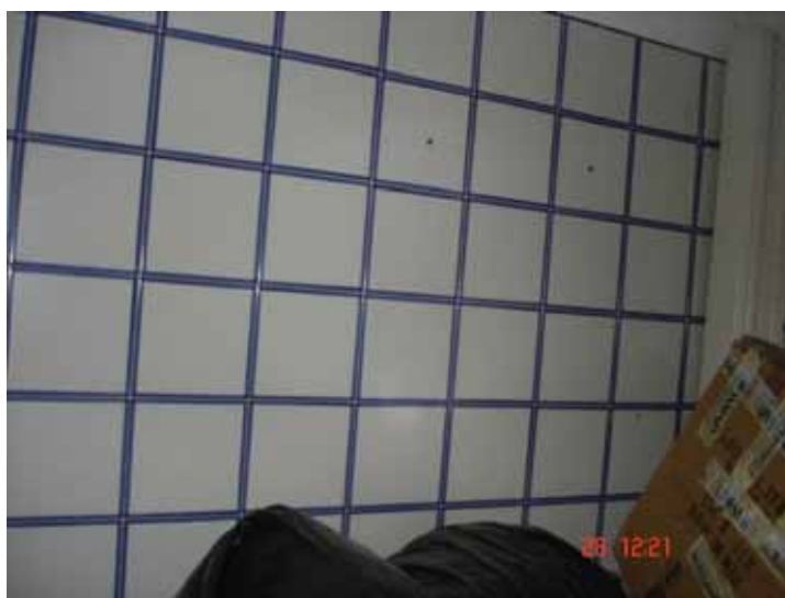
FOTO n° 6: Particolare vista rivestimento disimpegno locali igienici.
