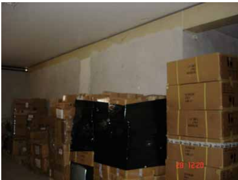
FOTO n° 4: Vista interna locale.
