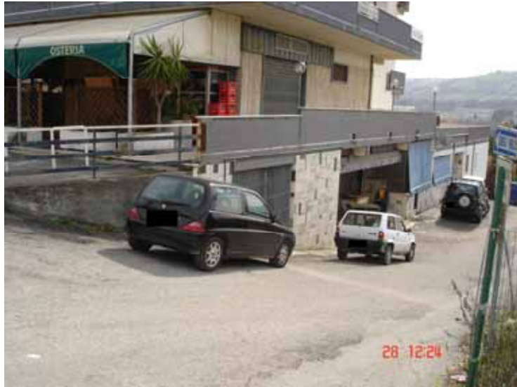
FOTO n° 1: Vista ingresso locale da rampa condominiale lato Ovest.
