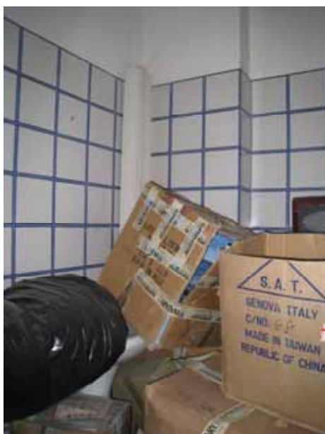
FOTO n° 8: Particolare vista rivestimento disimpegno locali igienici.
