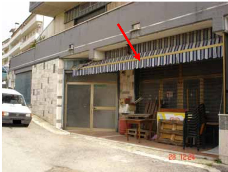
FOTO n° 2: Vista ingresso locale da rampa condominiale lato Ovest.
