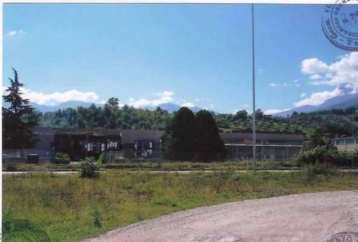
Foto n. 1 – Opificio - vista lato nord
