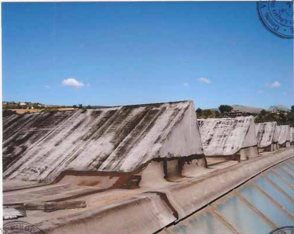
Foto n. 7 – Opificio – vista particolare copertura
