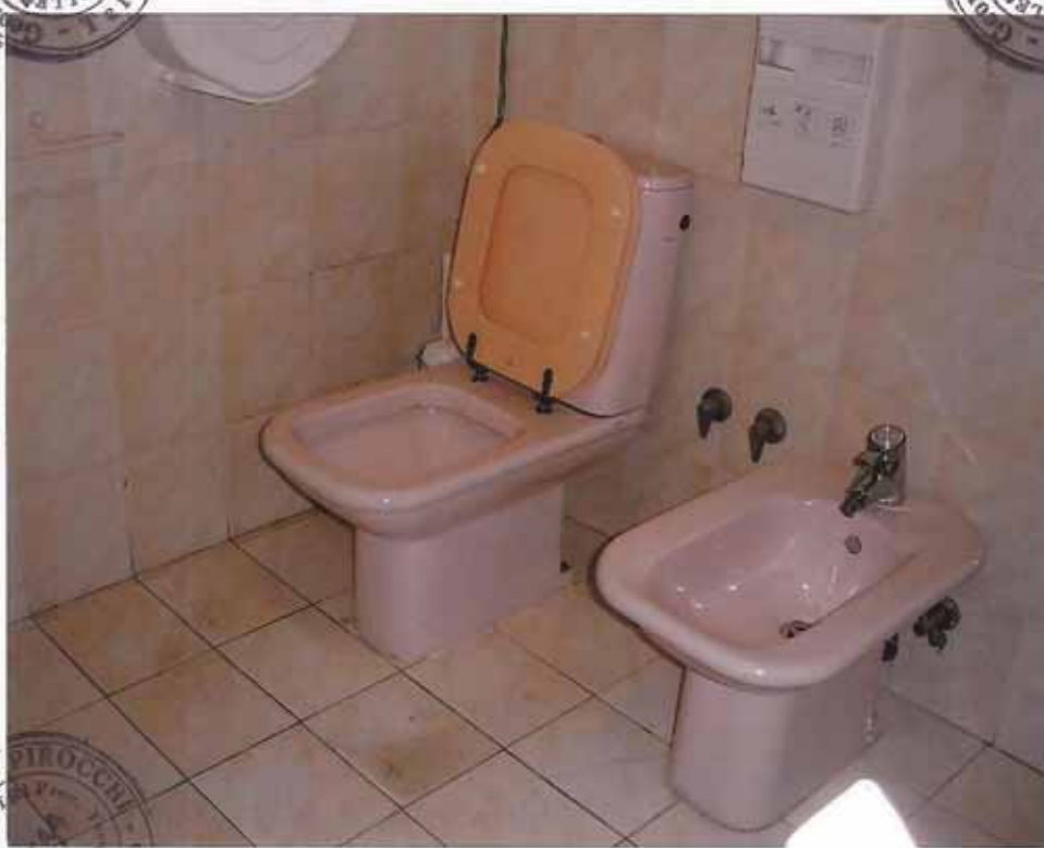
Foto n. 14 – Opificio – particolare interno (servizi)
