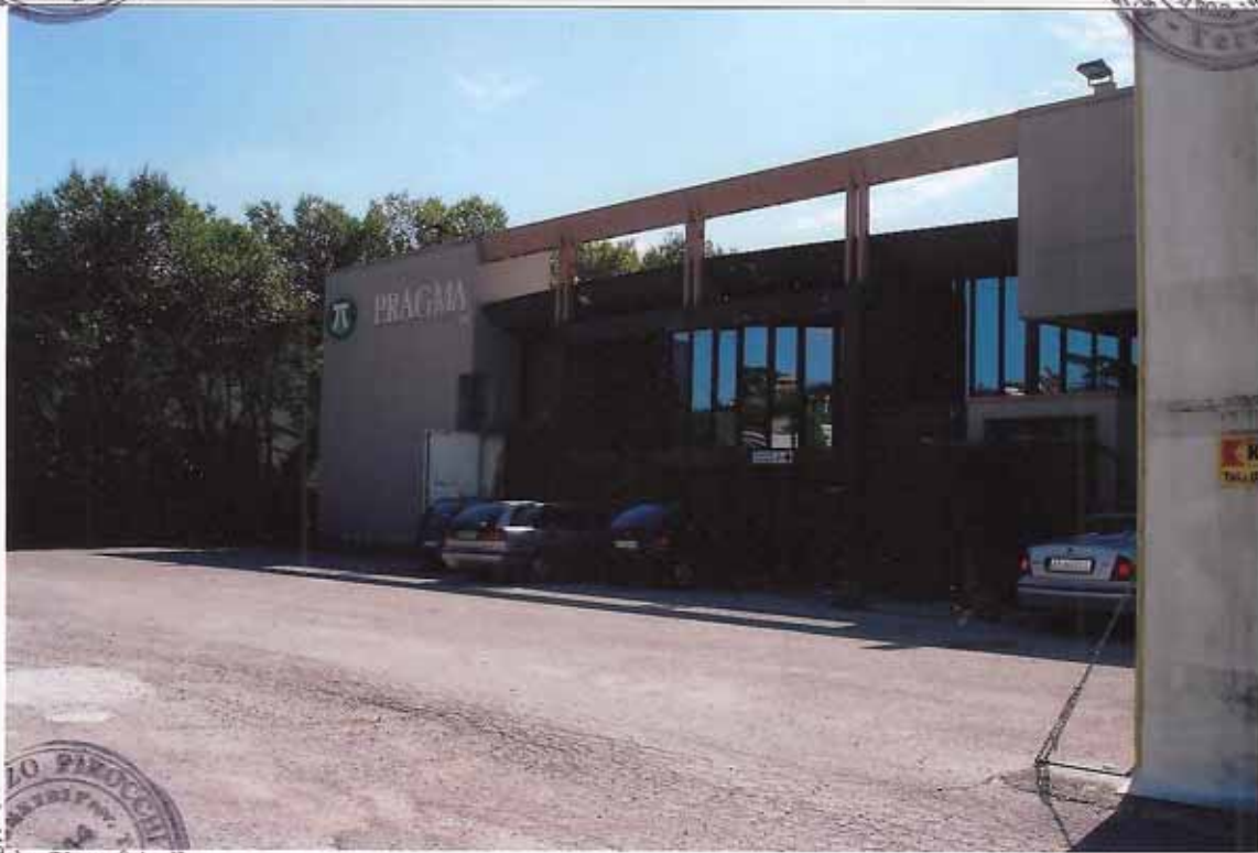
Foto n. 2 – Opificio - vista ingresso principale
