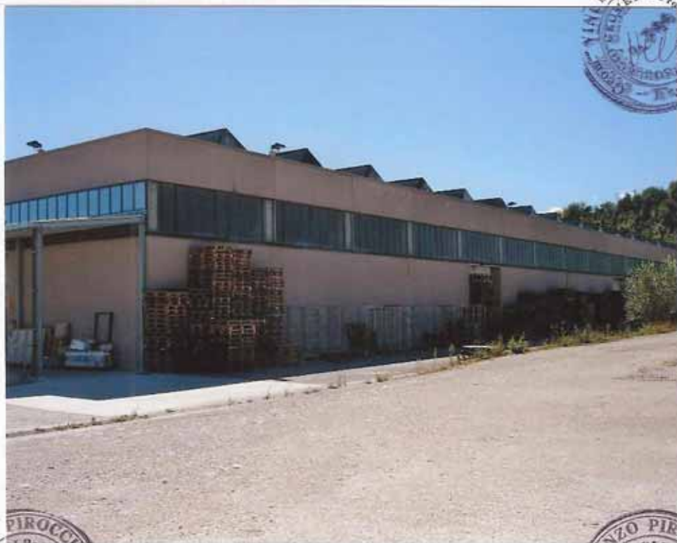
Foto n. 5 – Opificio – vista lato ovest
