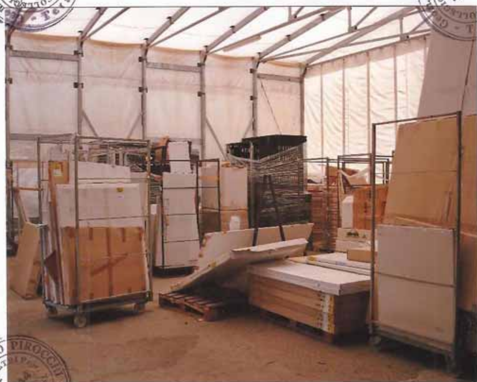
Foto n. 8 – Opificio – particolare interno “tunnel”
