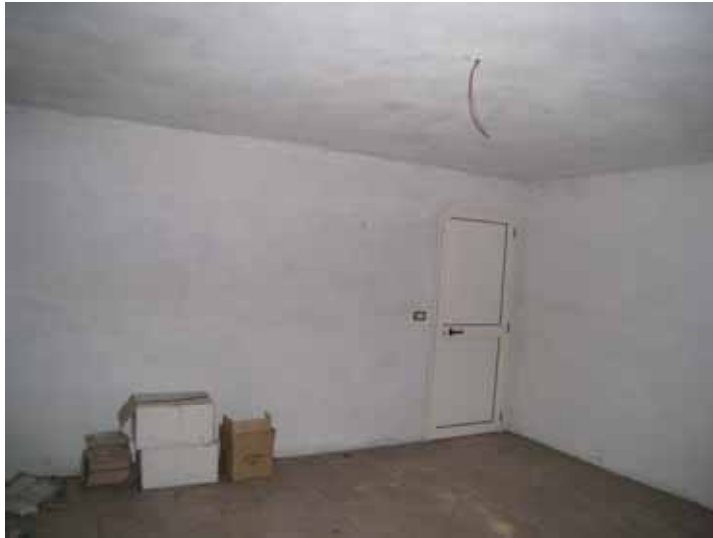
FOTO n° 7: Vista interna Box.
