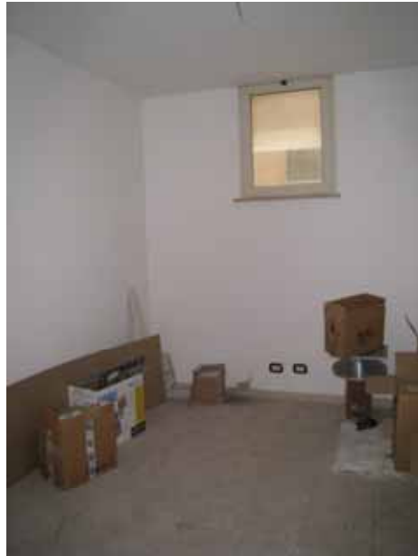
FOTO n° 13: Vista interna appartamento.
