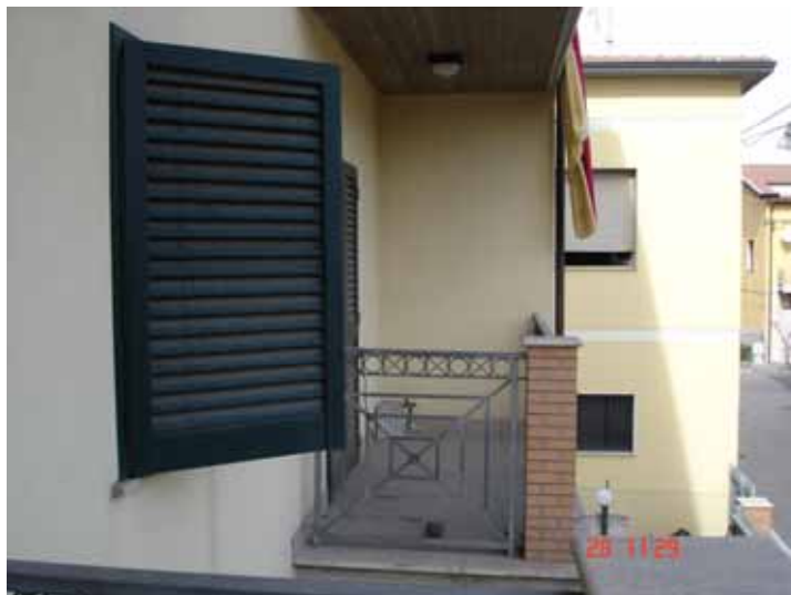
FOTO n° 21: Vista balcone lato Est.
