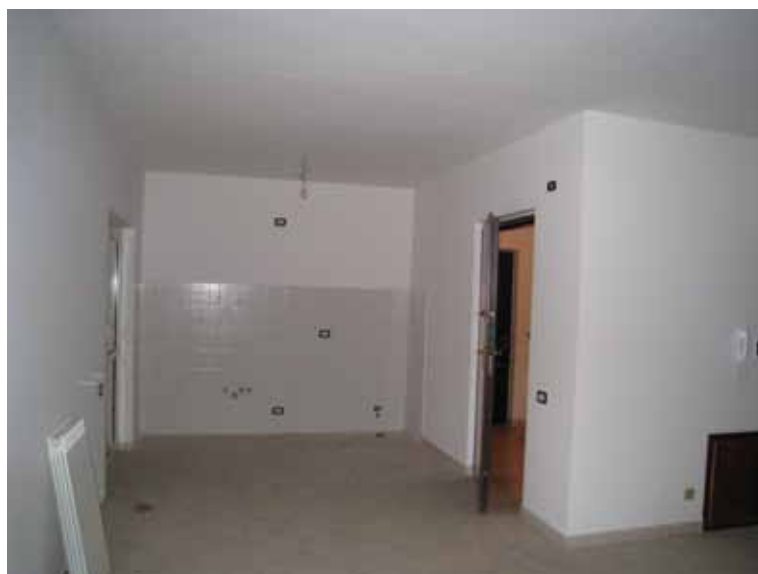
FOTO n° 12: Vista interna appartamento.
