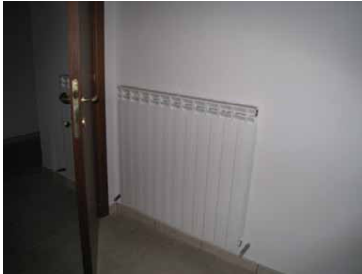
FOTO n° 16: Vista interna particolare corpo scaldante.
