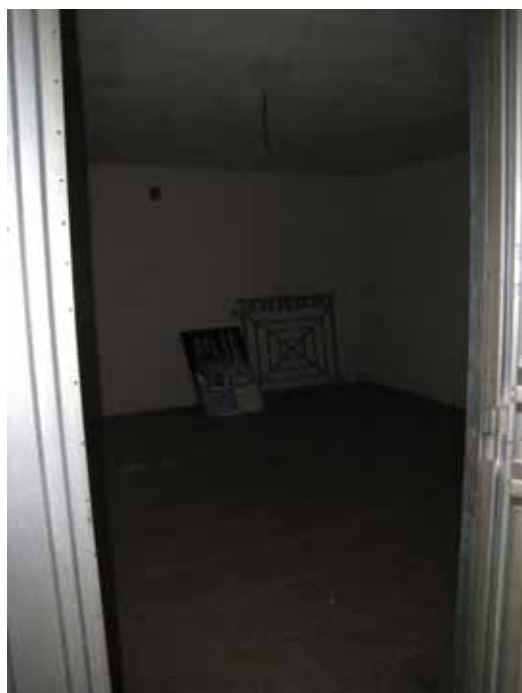
FOTO n° 6: Vista interna Box.
