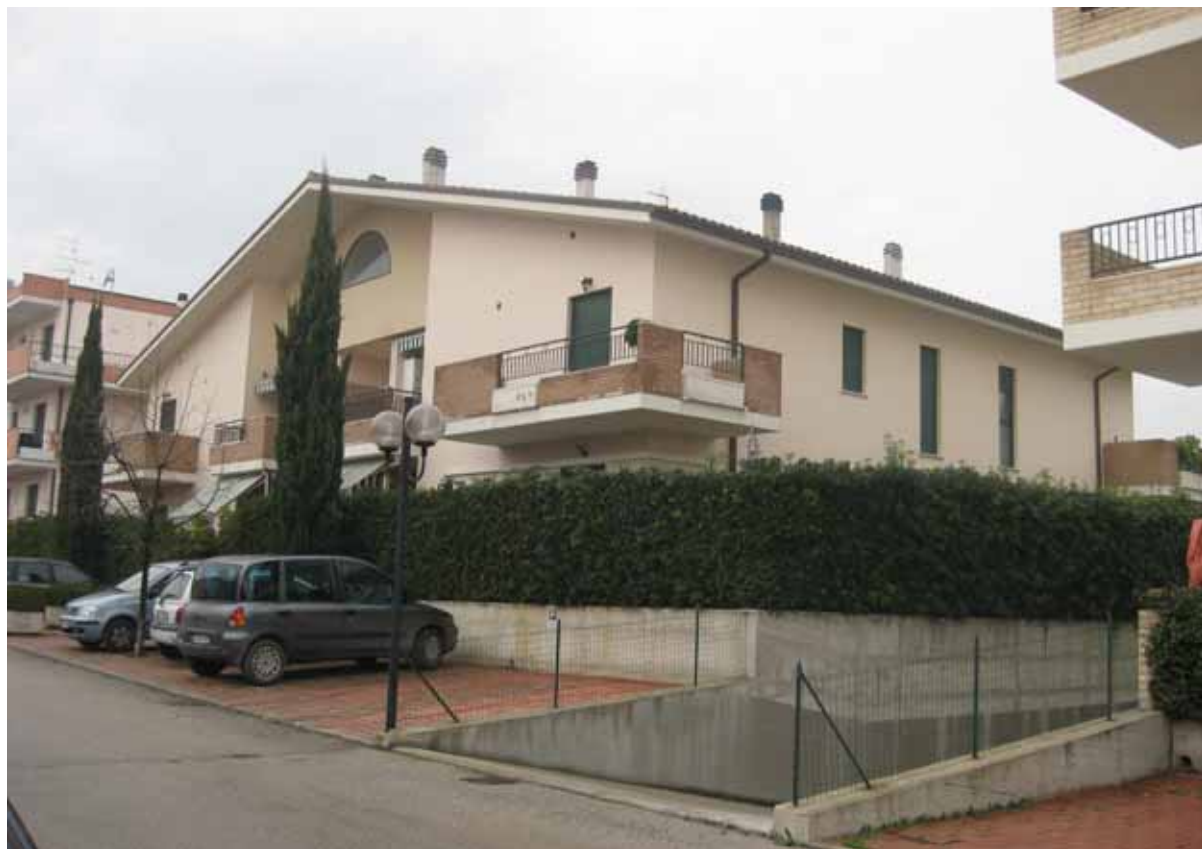
Foto n° 2: Vista esterna del fronte principale del fabbricato lato sud-est
