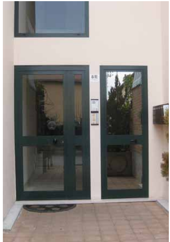
Foto n° 4: Particolare del vano di accesso al fabbricato
