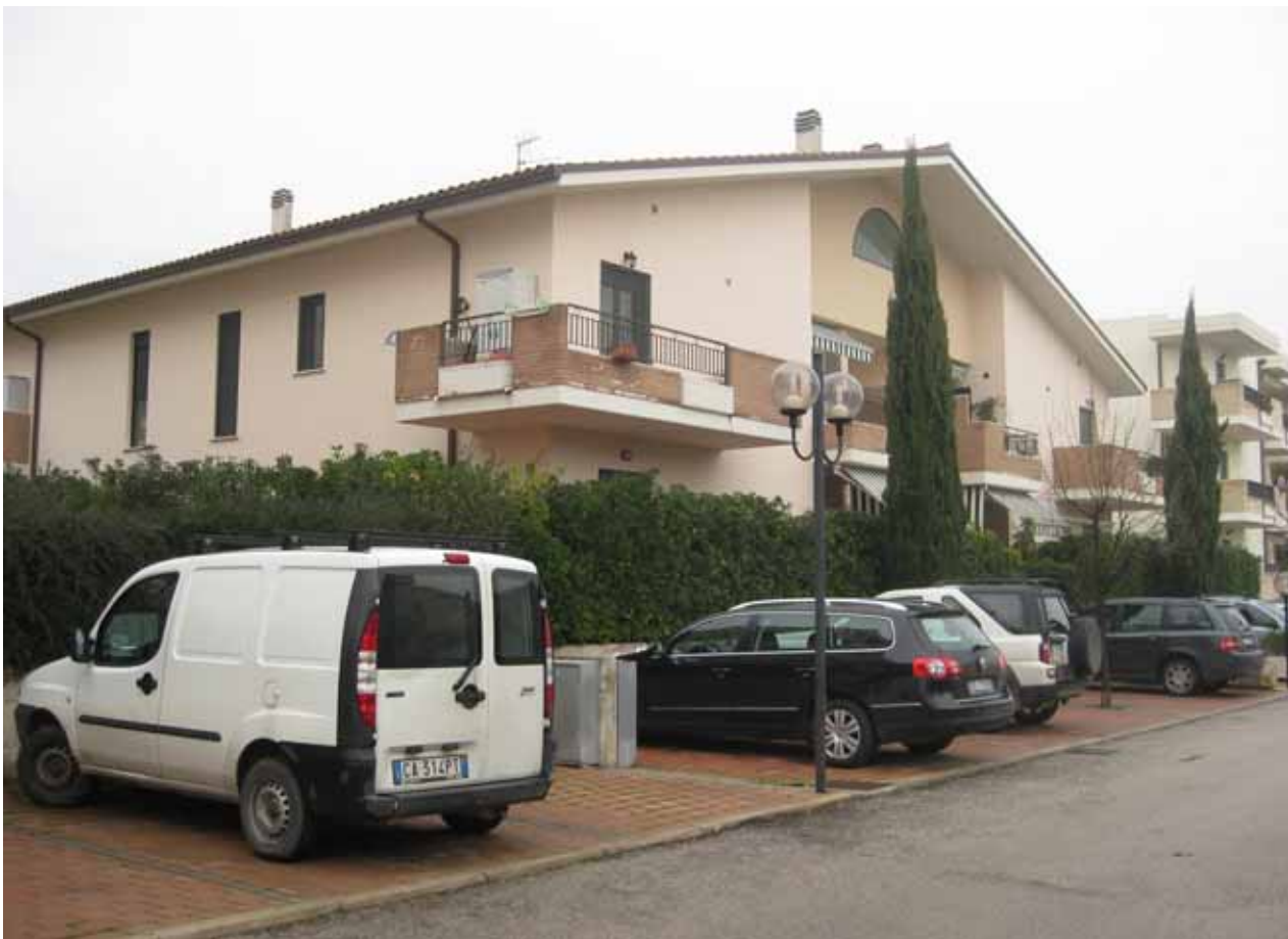
Foto n° 1: Vista esterna del fronte principale del fabbricato lato sud-ovest
