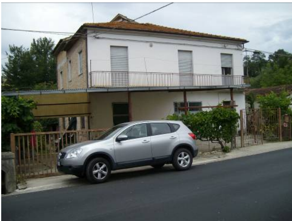
Foto n.1- Vista lato est
