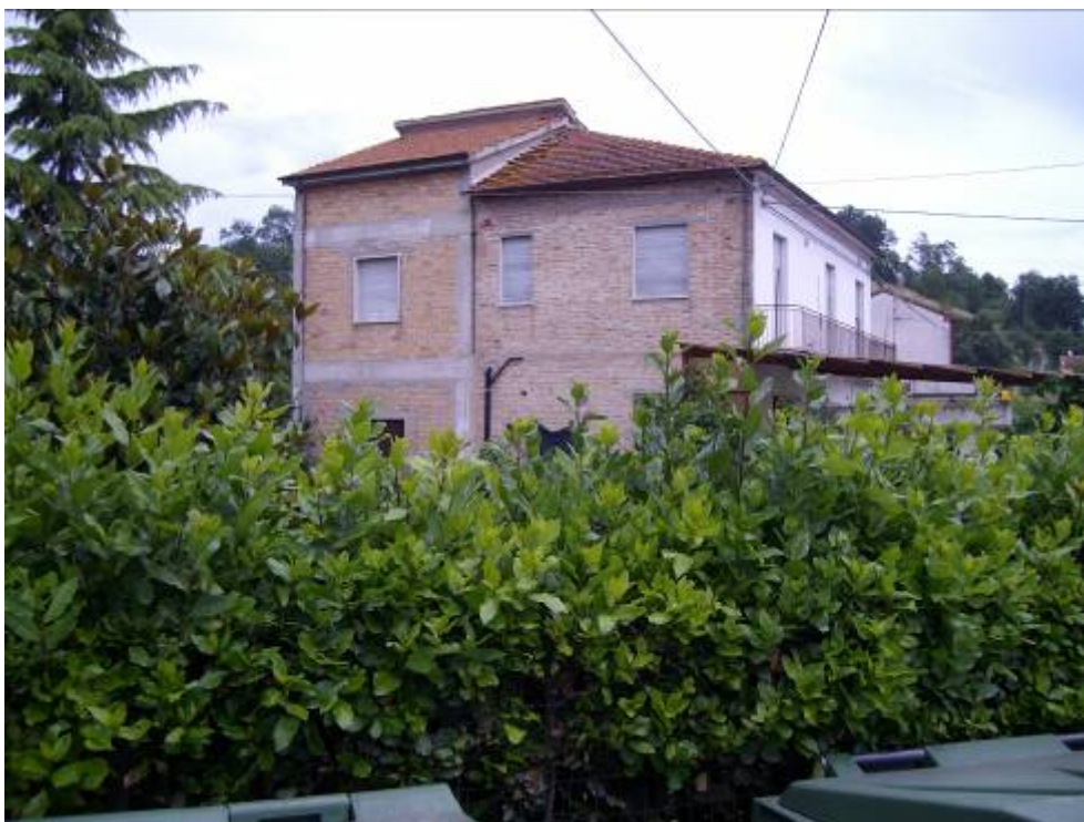
Foto n.2 – Vista lato sud
