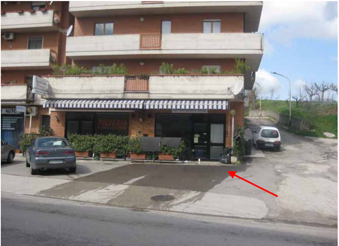
Foto n° 1: Vista del fronte principale da via Mirabilii
