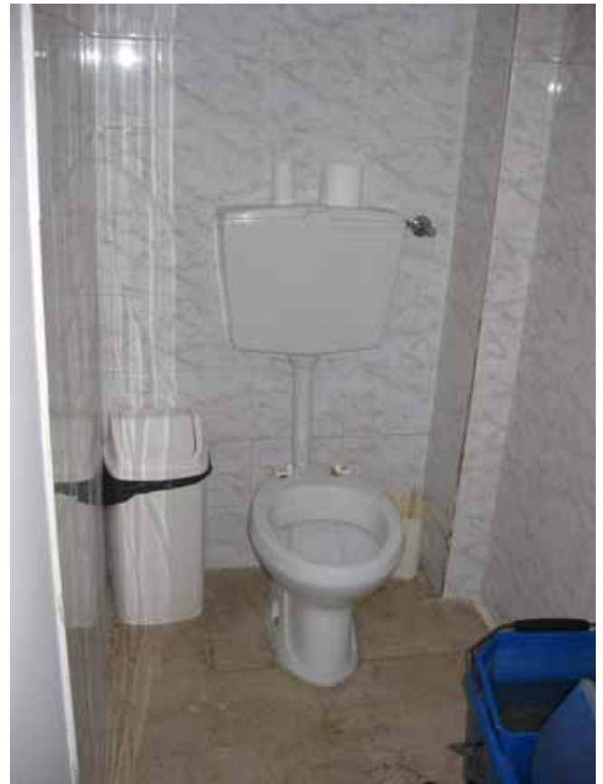
Foto n° 7: Particolare del locale wc
