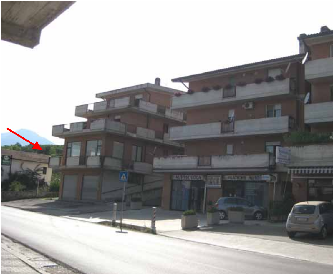
Foto n° 1: Vista del fronte principale da via Mirabili
