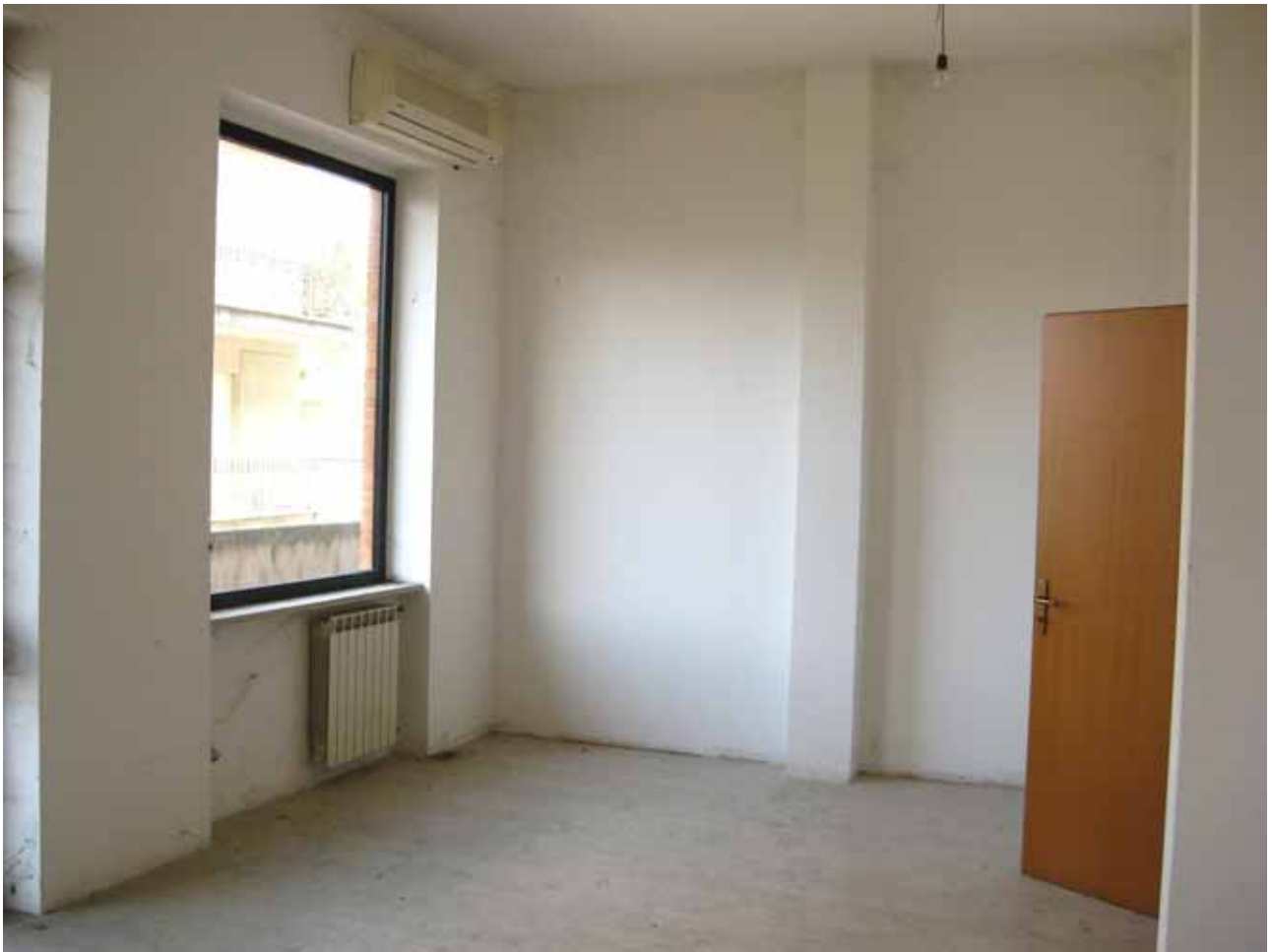
Foto n° 5: Interno di un locale sito sul fronte ovest
