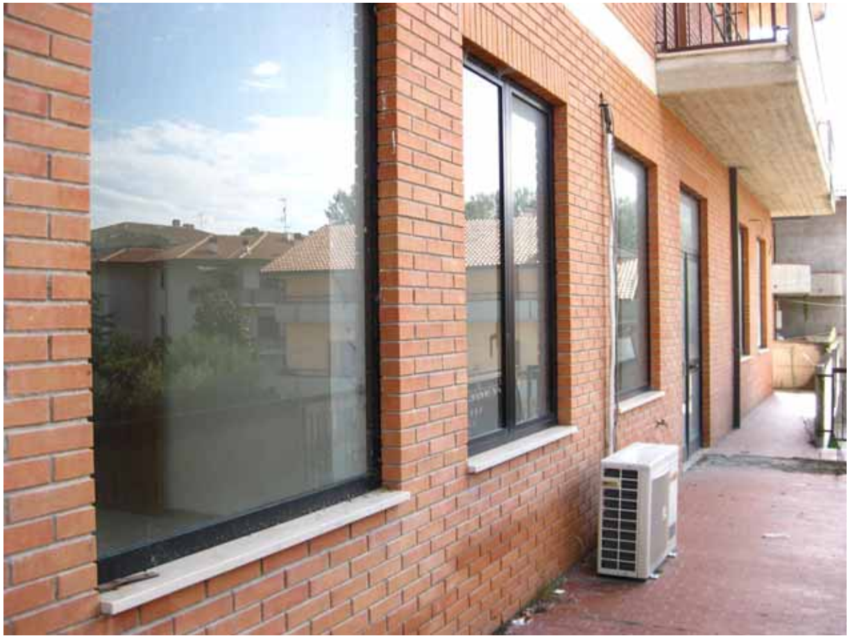
Foto n° 3: Particolare del balcone sul fronte ovest del fabbricato
