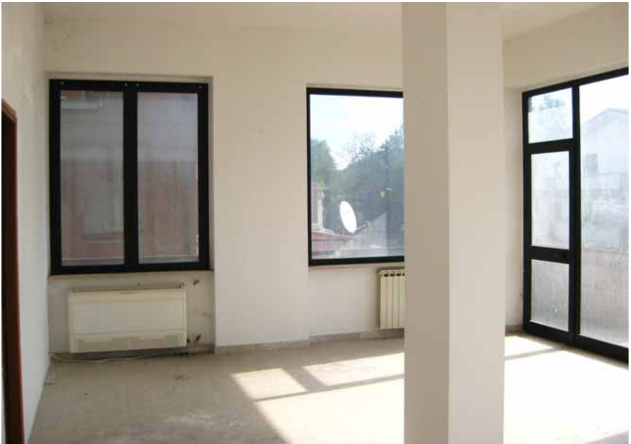
Foto n° 8: Particolare del locale sito lungo l'intero lato sud
