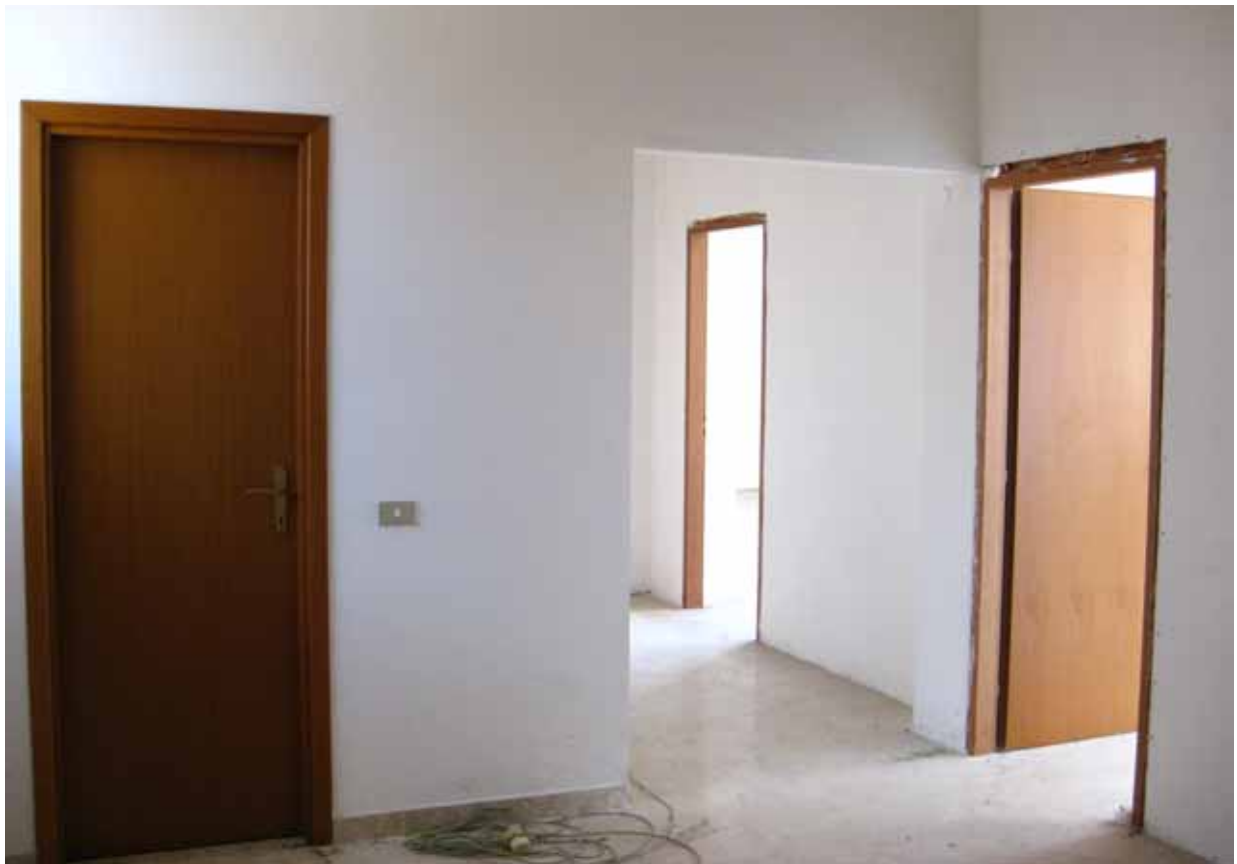
Foto n° 4: Particolare dell'interno dell'unità immobiliare, lato ovest
