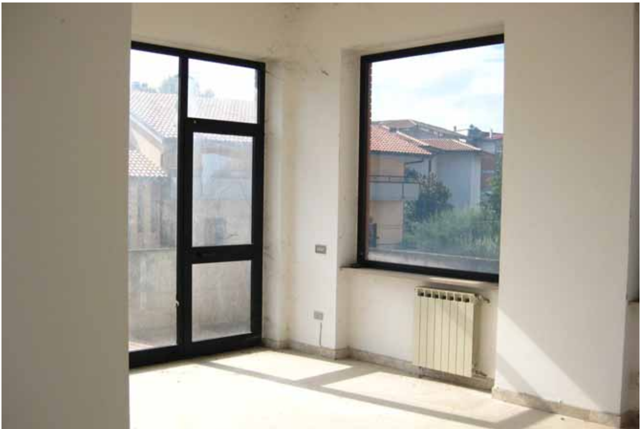
Foto n° 9: Particolare del locale prospiciente via Mirabilii, angolo sud-ovest
