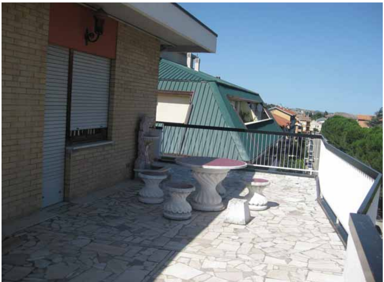
Foto n° 16: Particolare del terrazzo esterno su via Tripoti
