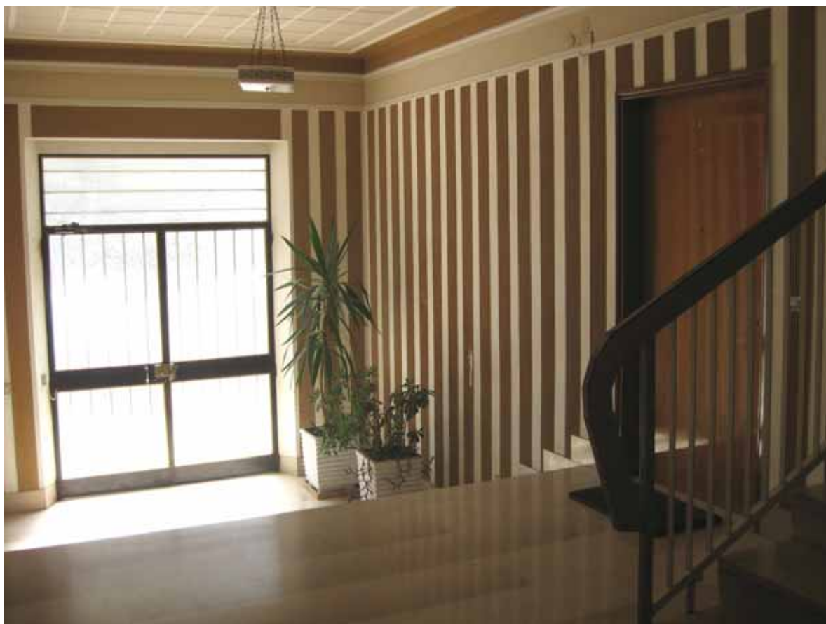
Foto n° 3: Vista dell'androne di ingresso al vano scala
