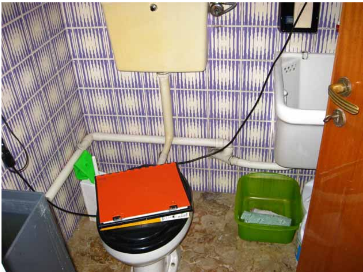
Foto n° 14: Piccolo locale wc sito nella zona d'ingresso
