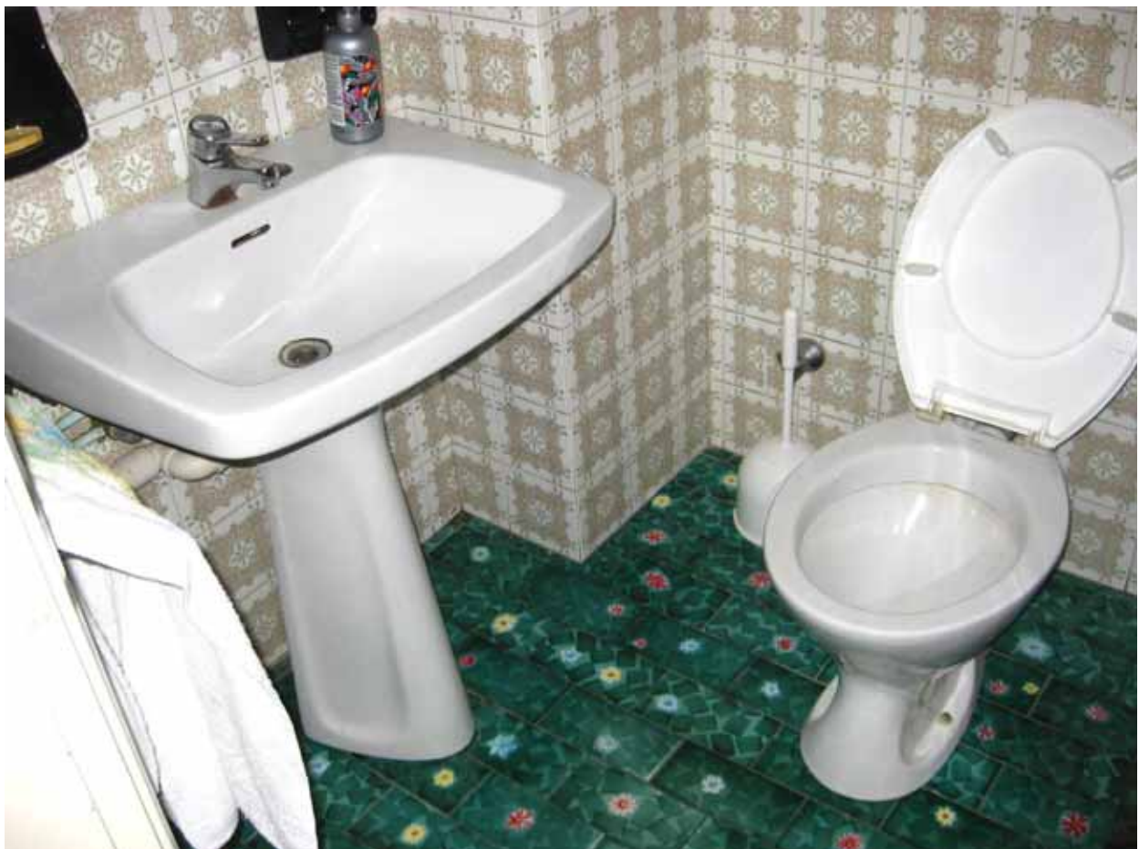
Foto n° 11: Particolare del locale wc principale
