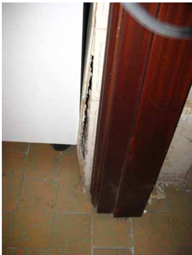
Foto n° 9 e n° 10: Particolari su problemi di infiltrazioni e macchie di umidità sulle pareti interne
