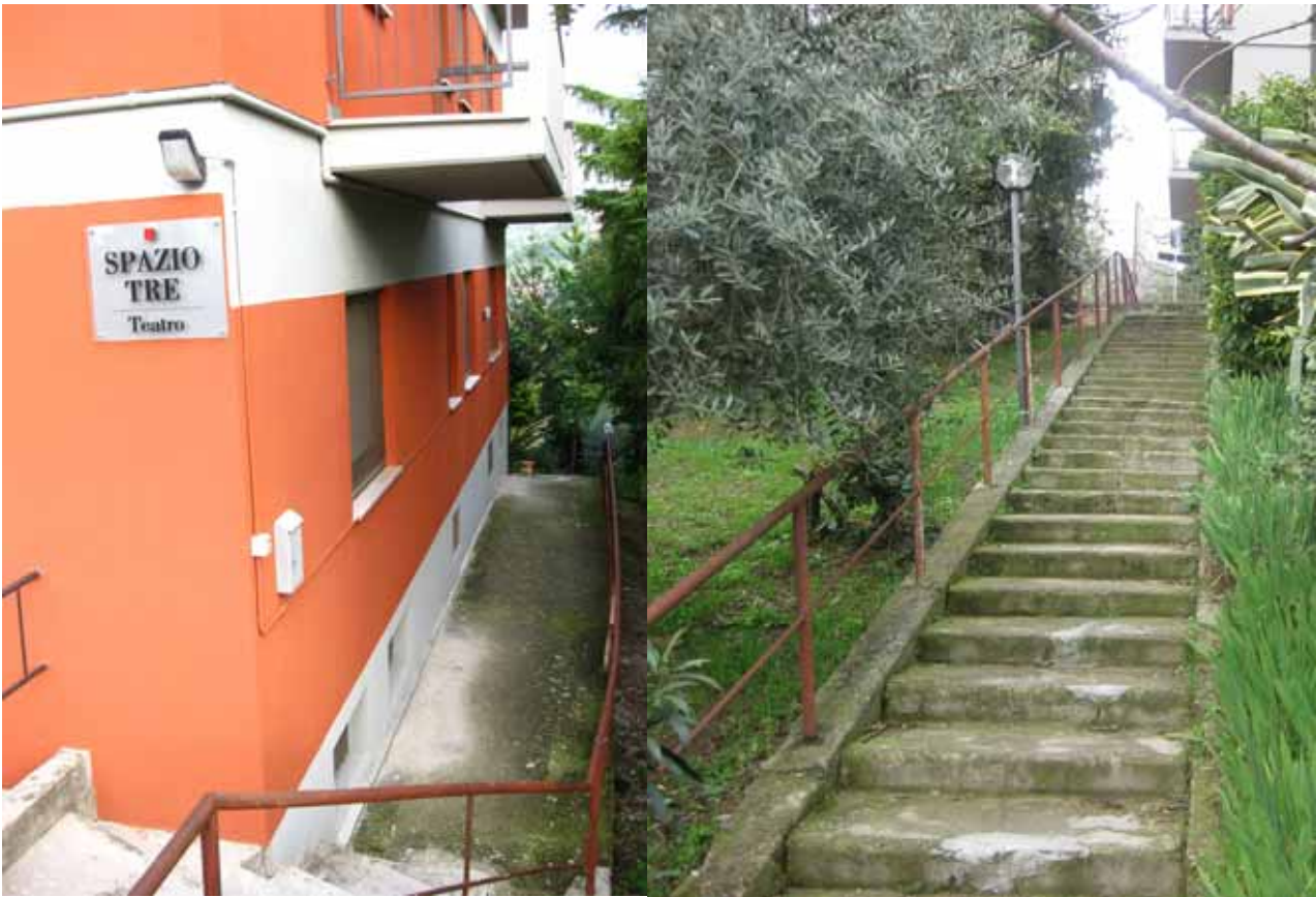
Foto n° 3 e n° 4: Percorso e scalinata di accesso da via Cona
