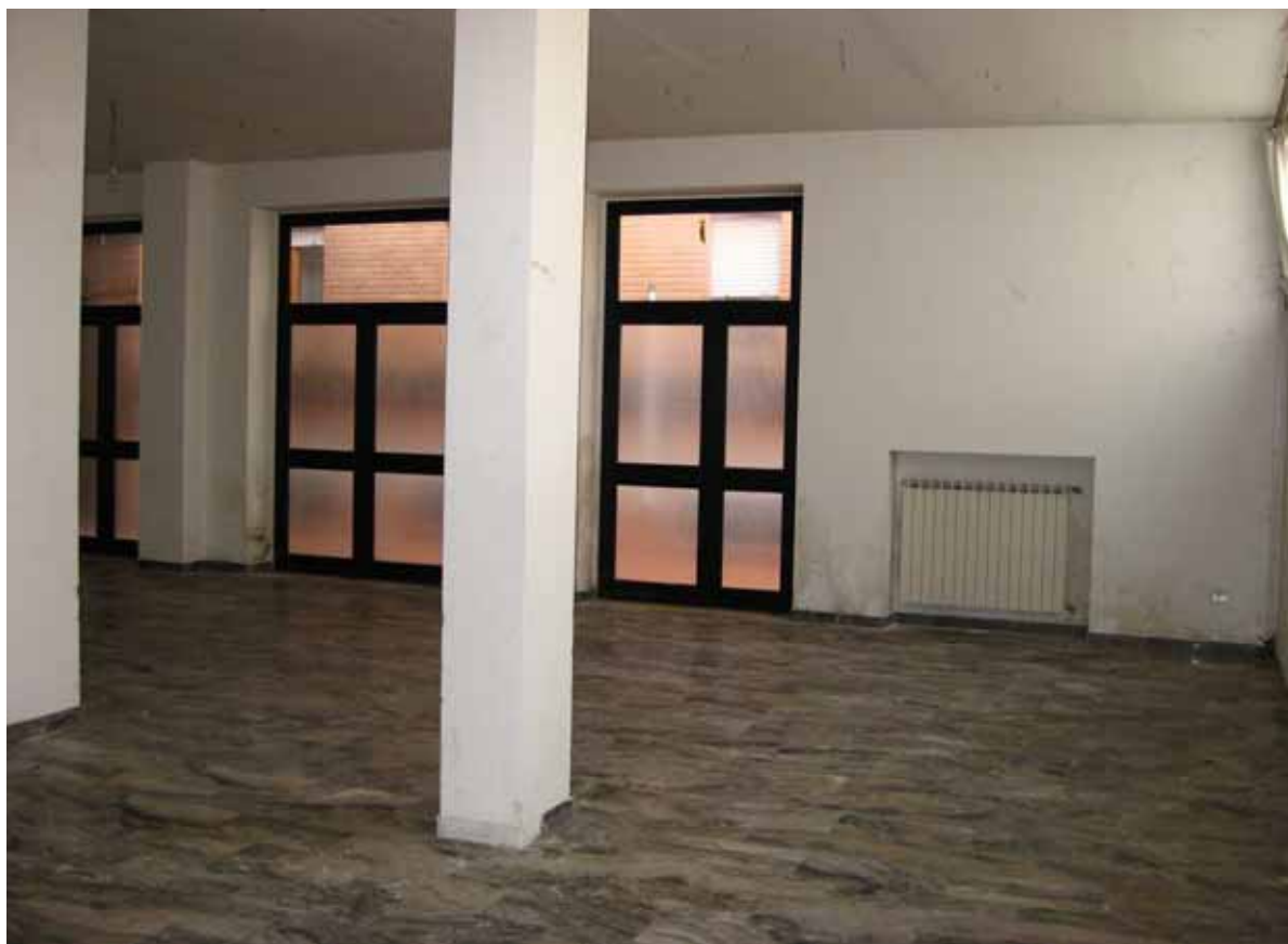
Foto n° 6: Interno del locale adibito ad attività commerciale, lato sud
