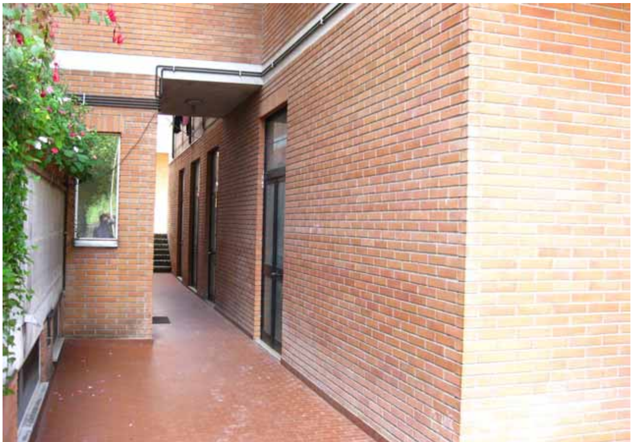
Foto n° 2: Vista del passaggio comune con accessi all'unità immobiliare
