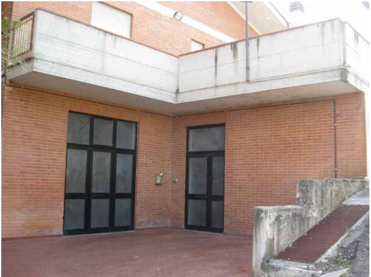
Foto n° 3: Particolare del fronte dove sono ubicati gli accessi principali all'unità edilizia
