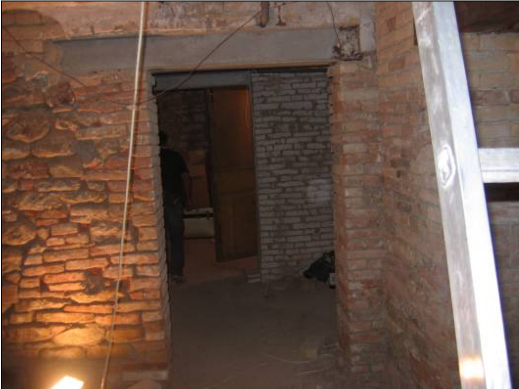
foto 15 locale al piano primo sottostrada
