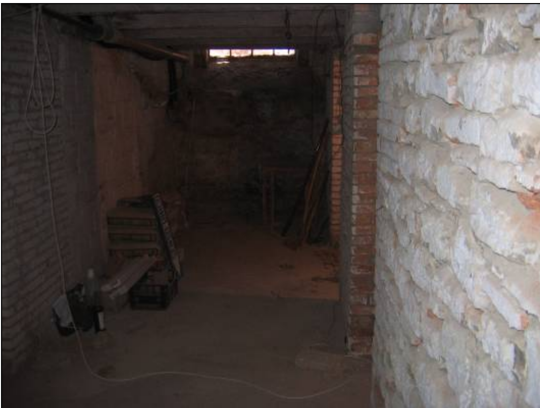
foto 16 locale al piano primo sottostrada
