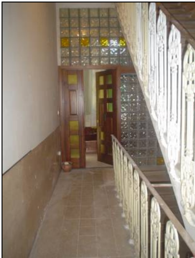
foto 4 vano scala piano primo
