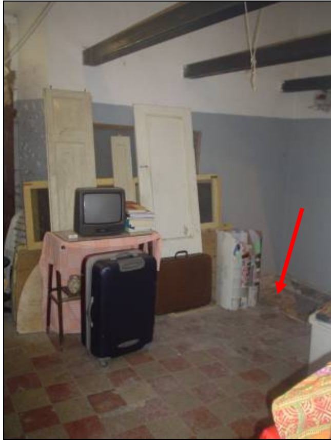
foto 13 botola di collegamento con il locale al piano primo sottostrada
