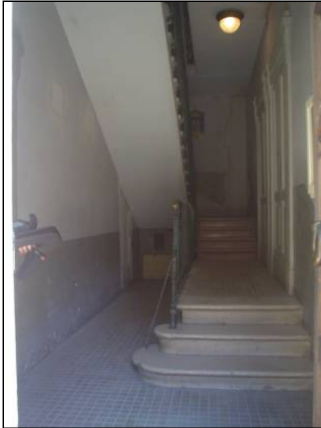
foto 3 vano scala piano terra
