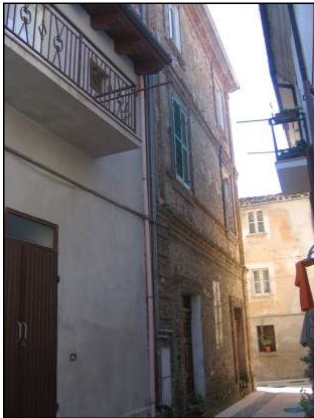
foto 2 prospetto su Via del Russo
