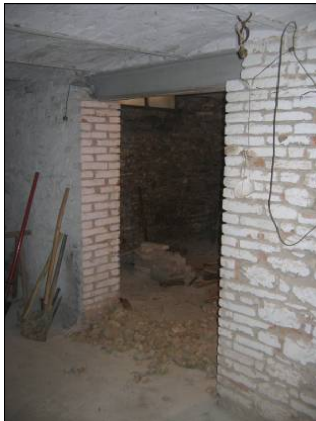
foto 18 locale al piano primo sottostrada particolare del solaio a voltine e della trave in ferro
