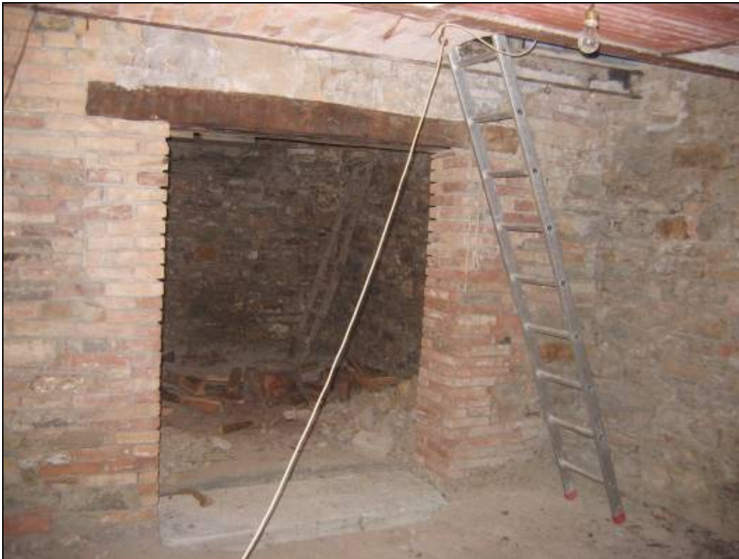
foto 14 locale al piano primo sottostrada
