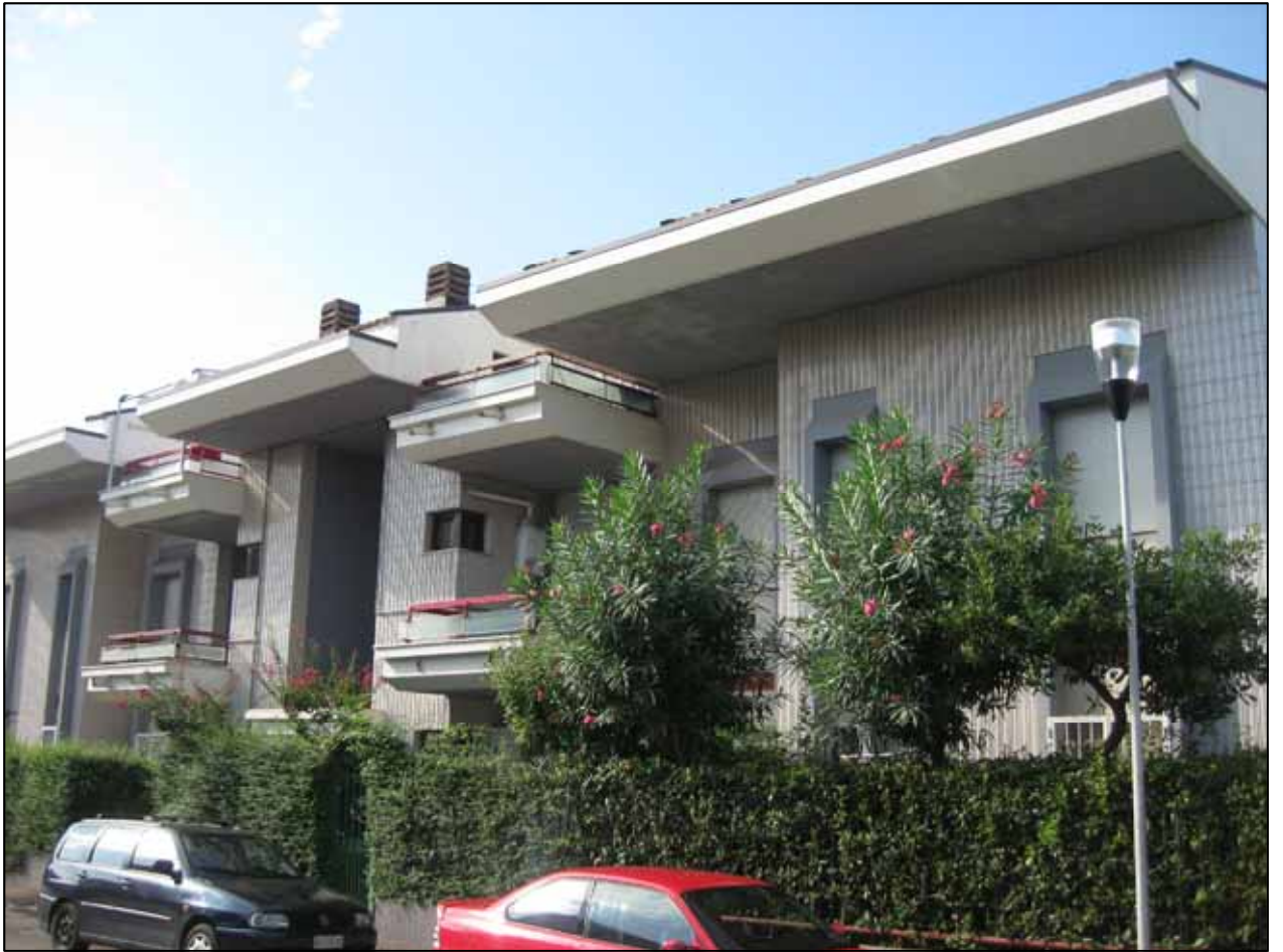
Vista del fabbricato da via Genova
